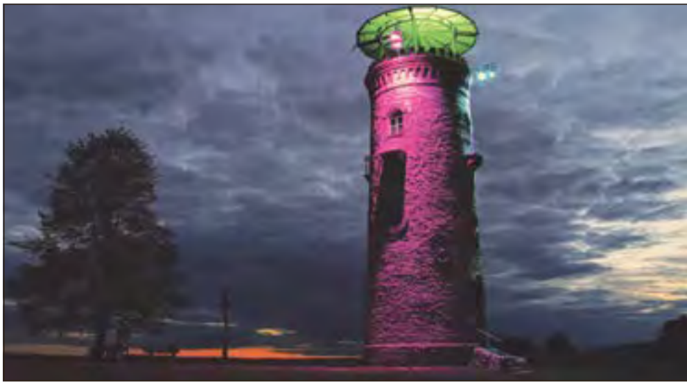
Ende September soll der Bismarckturm wieder leuchten.
